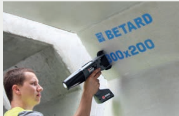
→ Wygodne znakowanie betonowych prefabrykatów. Nadruki odporne na promieniowanie słoneczne i wilgoć
